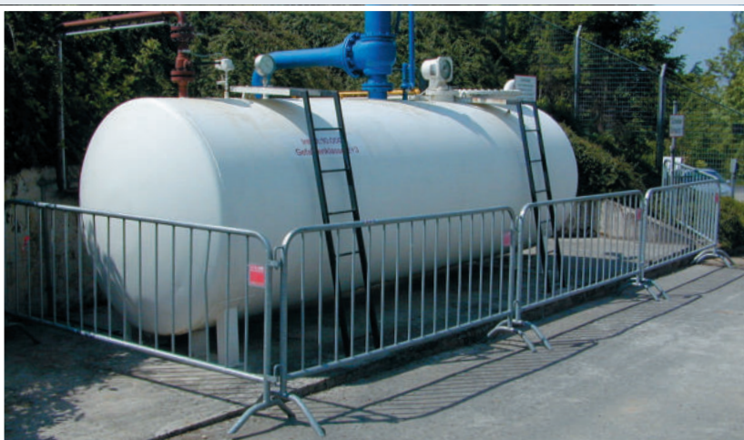
HAGOSTOP classic - provisorische Absperrung eines Gastanks
