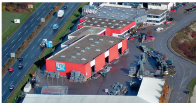
Zentrale HAGO A-4600 Wels
